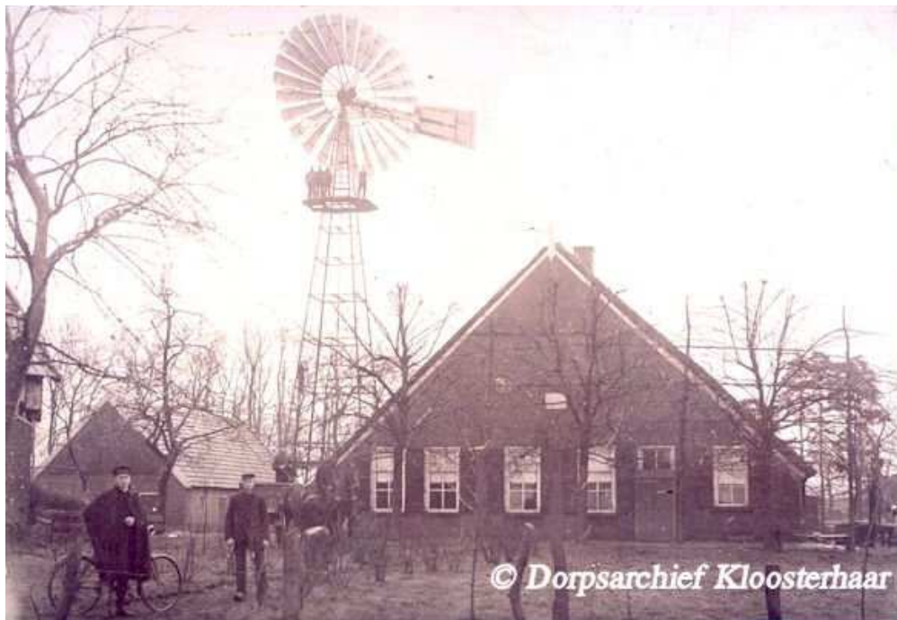
Boerderij Balderhaar met windmolen in 1910. Met fiets een Hollandse douanebeambte, daarnaast Albertus Weerts. De molen diende ter aandrijving van verschillende landbouwmachines o.a. de strohakselaar. De voormalige boerderij staat er nog en is nog steeds in gebruik als vee stalling. Dendrologisch onderzoek zou de ouderdom kunnen prijsgeven van de gebinten. In augustus 2006 heb ik samen met Dr. Everhard Jans de nog op het erf staande voormalige schaapskooi ingemeten en ingetekend.
